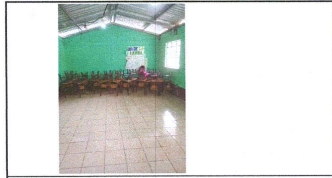
Foto 6: Sustrucción de piso de torta por piso cerámico aula de tercero.
