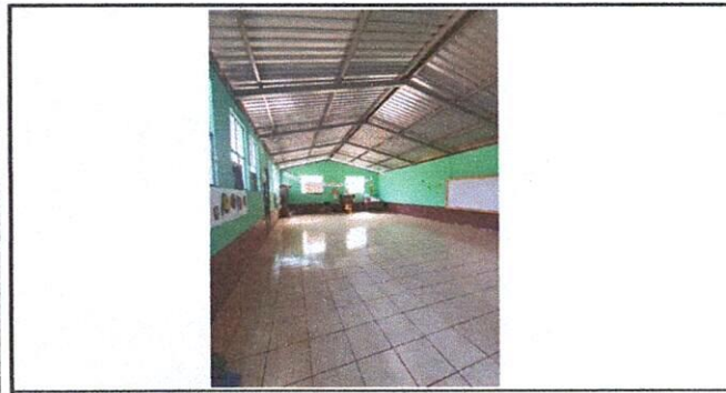
Foto 5: Sustrucción de piso de torta por piso cerámico aula de Sexto
