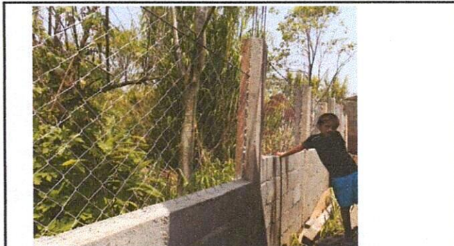
Foto 3: Sustrucción de un metro malla por muro perimetral de la parte de atrás del centro educativo.
