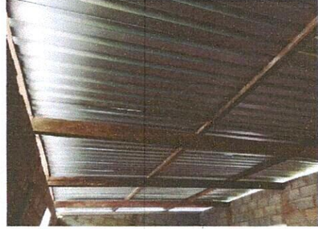
Foto 14: Cubierta de lámina de bodega sustituido.
